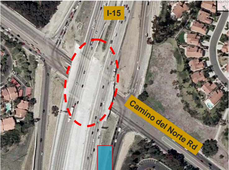
Camino del Norte bridge, San Diego, CA
