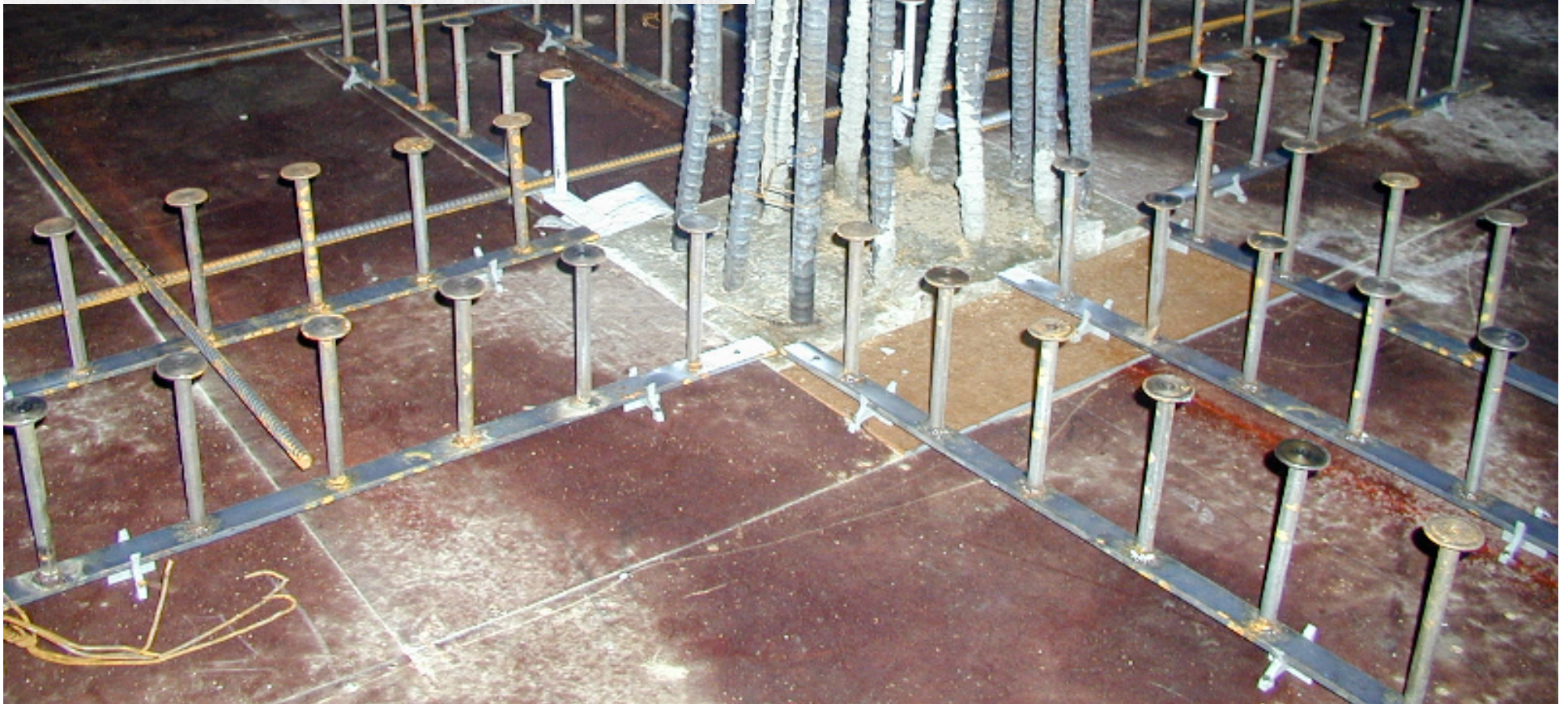
Fig. R11.12.3(a)—Slab stirrups
