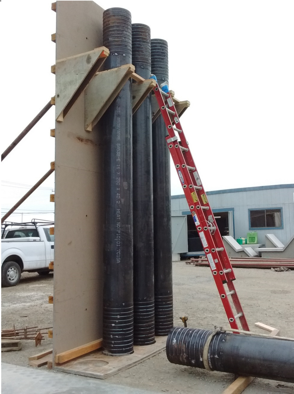
(e) Concrete pouring setup
